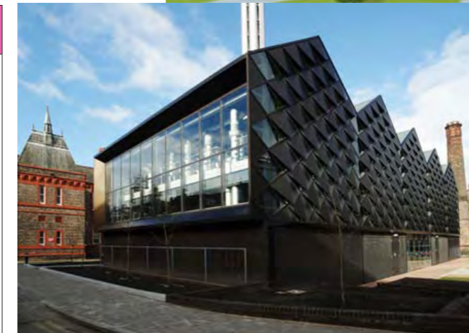
CHP 'energy centre'
